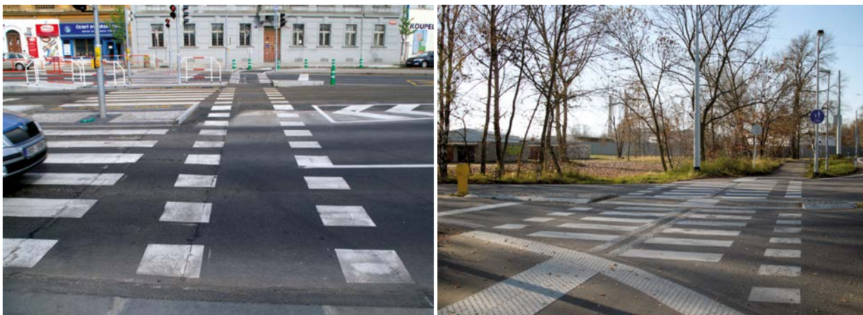
Přejezd pro cyklisty přimknutý k přechodu pro chodce (vlevo) a sdružený přechod pro chodce a přejezd pro cyklisty (foto vpravo).
